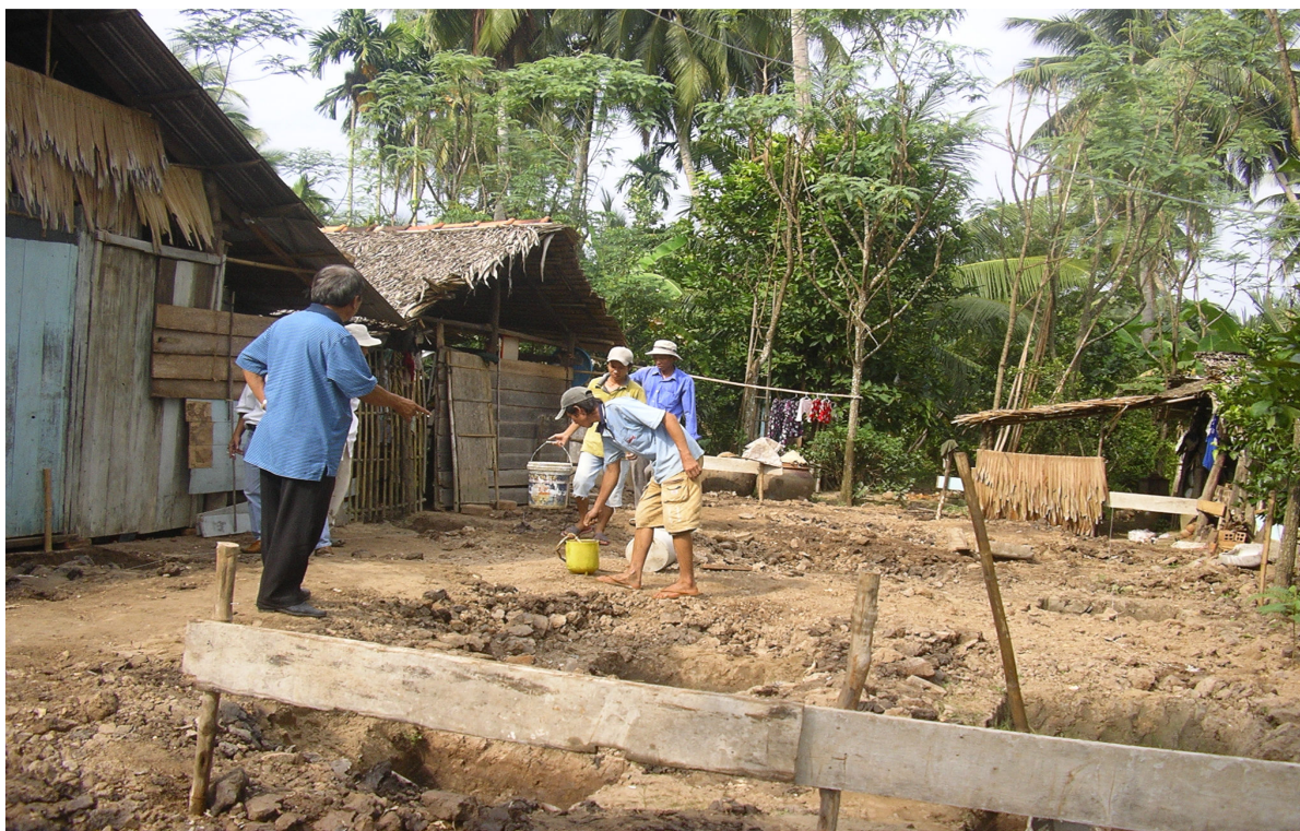
Những chuẩn bị xây cất trên nền căn nhà cũ của 24 NV Sĩ
